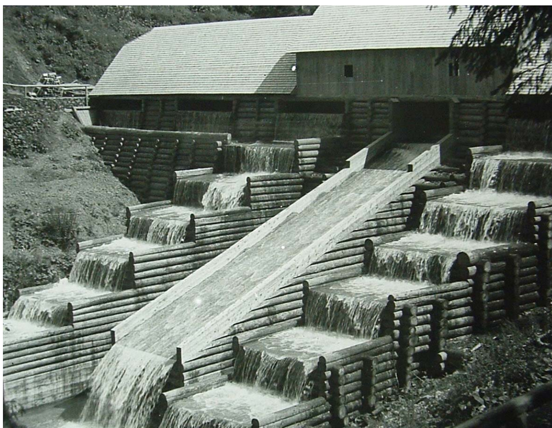
Obrázek č. 3: Příklad srubové hráze vodní nádrže pro plavení dříví – z archivu autora
